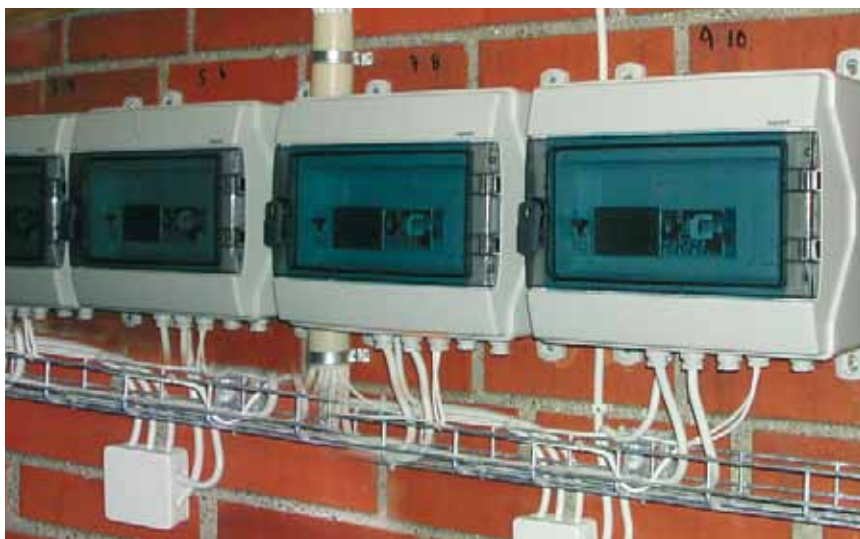
2 Блоки управления вентиляторами VBP
