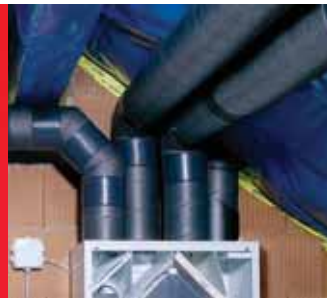
Невероятная экономия времени, затрачиваемого на монтаж: IsoPipe, система изолированных воздуховодов.
