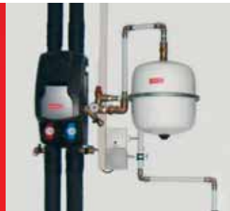
Монтаж гидравлического блока, необходимого для подключения солевого грунтового теплообменника.
