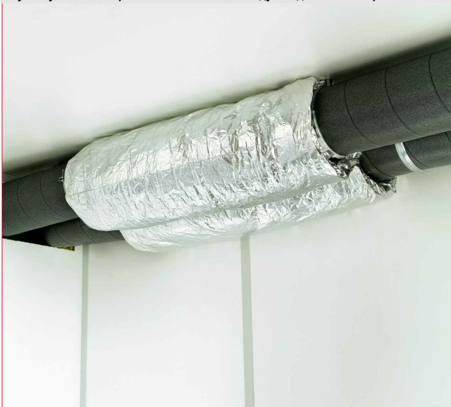
Шумоглушитель на приточном и вытяжном воздуховоде SDE с IsoPipe®
