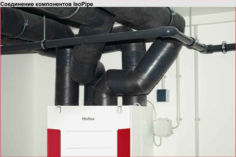
Соединение компонентов IsoPipe
