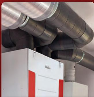
IsoPipe® представляет собой практичное альтернативное решение спирально-навивным трубам с последующей теплоизоляцией. Изолированные воздуховоды IsoPipe® идеально подходят для подачи внешнего и вытяжного воздуха, а также перемещения приточного и отводимого воздуха в подвалах и других холодных участках. Система изолированных воздуховодов круглого сечения эффективно предупреждает образование конденсата и значительно экономит время на монтаж.
