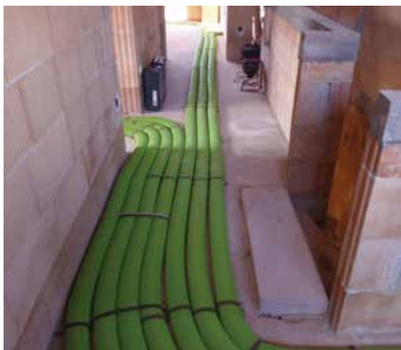
Компактное размещение плоских воздуховодов Air Excellent в конструкции пола
